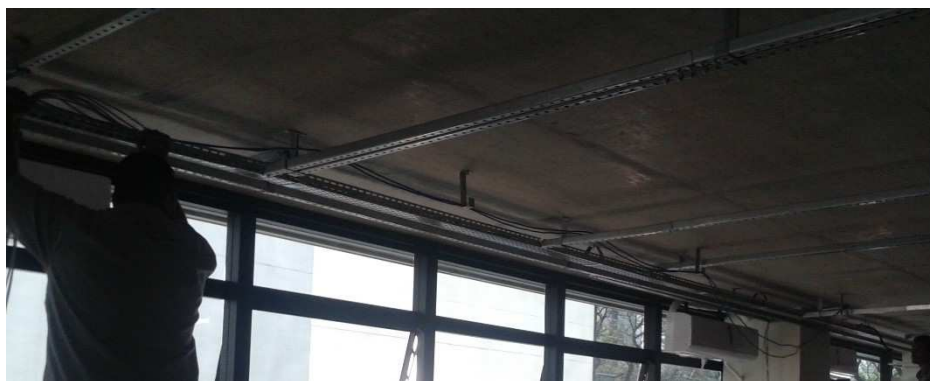
Foto 18- Infraestrutura Elétrica - Eletrocalhas, perfilados e passagem dos cabos
