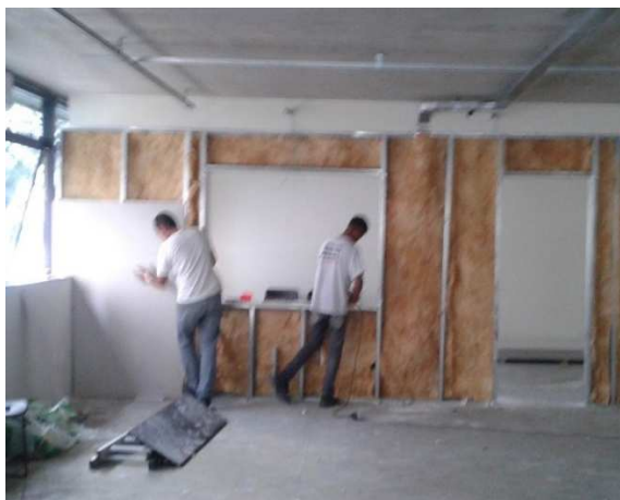
Foto 6 - Execução Lã de vidro em Parede em Dry Wall da sala de projeção
