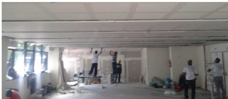
Foto 8 - Execução do forro de gesso liso e e perfurado
