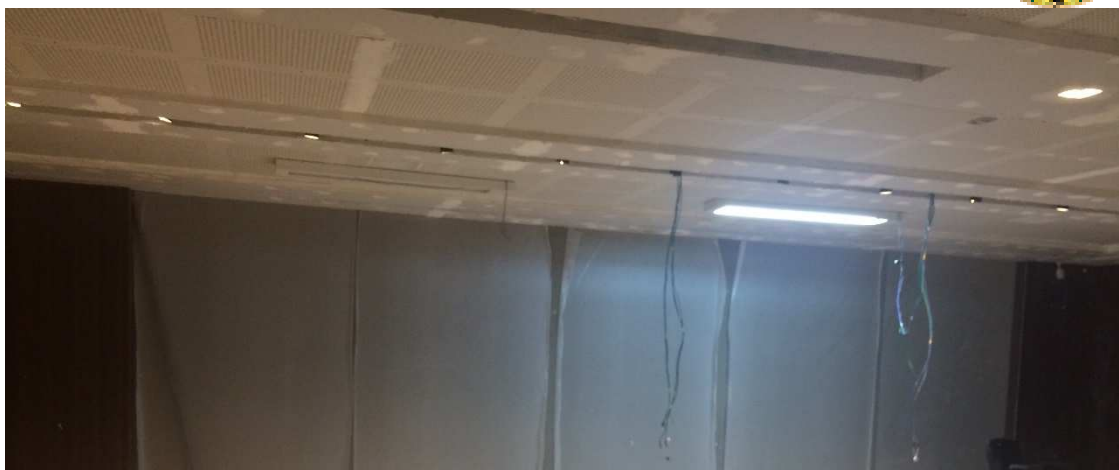
Foto 23- Cabos da iluminação do palco
