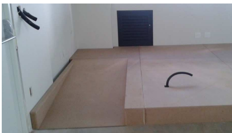
Foto 28 - Palco do auditório em MDF – Vista da rampa
