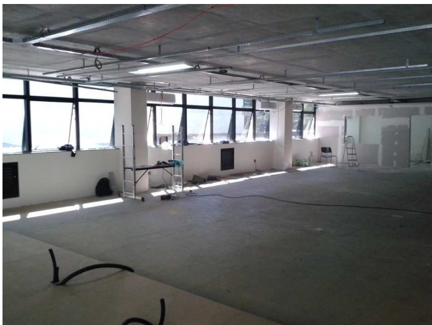
Foto 16- Infraestrutura Elétrica - Eletrodutos para as tomadas, Eletrocalhas, perfilados
