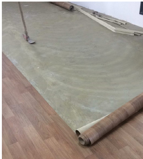
Foto 1 - Remoção piso e rodapé vinílico existente
