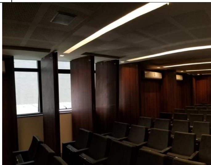
Foto 11 - Painéis móveis (pivotantes) em MDF com ripado de 2,5x2,5cm
