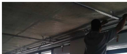
Foto 4 - Retirada de perfilados
