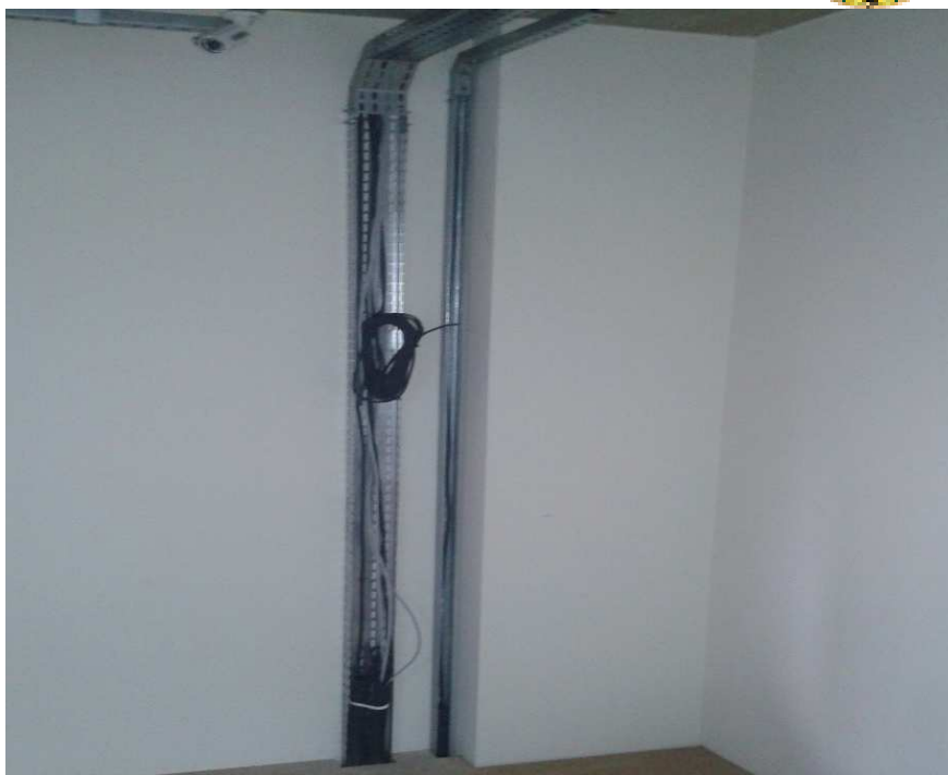
Foto 17- Infraestrutura Elétrica - Eletrodutos, Eletrocalhas, perfilados e passagem dos cabos
